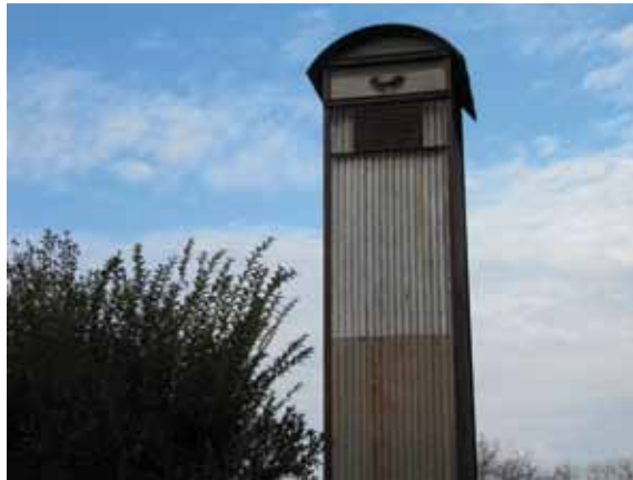
Ancien poste de transformateur électrique à Stutzheim
